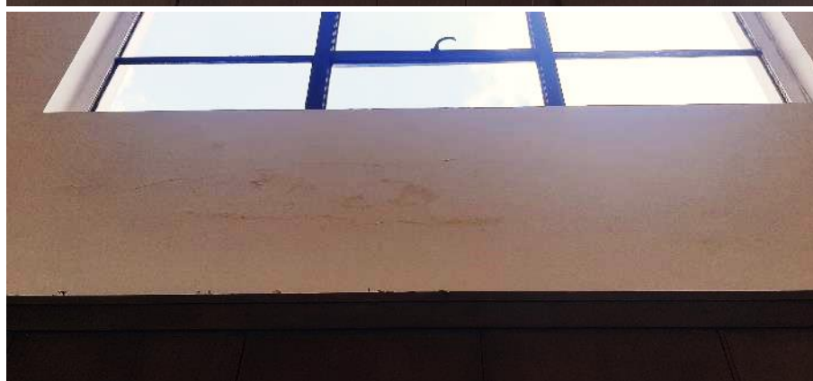
Imágenes 188-189: filtraciones presentes en la pared oriental de dirección
