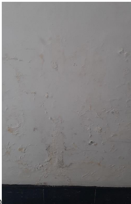
Imágenes 20 y 21: humedad muro occidental frente a galería Vásquez
