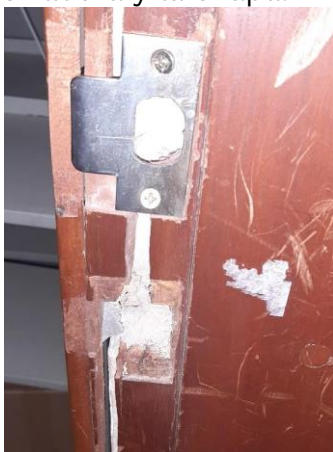
Imagen 118: Deterioro de la puerta de material en tránsito
