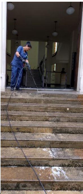
Imágenes 148-150: proceso de hidrolavado de pisos externos (piedra muñeca)
