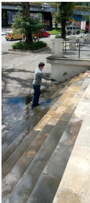
Imágenes 148-150: proceso de hidrolavado de pisos externos (piedra muñeca)
