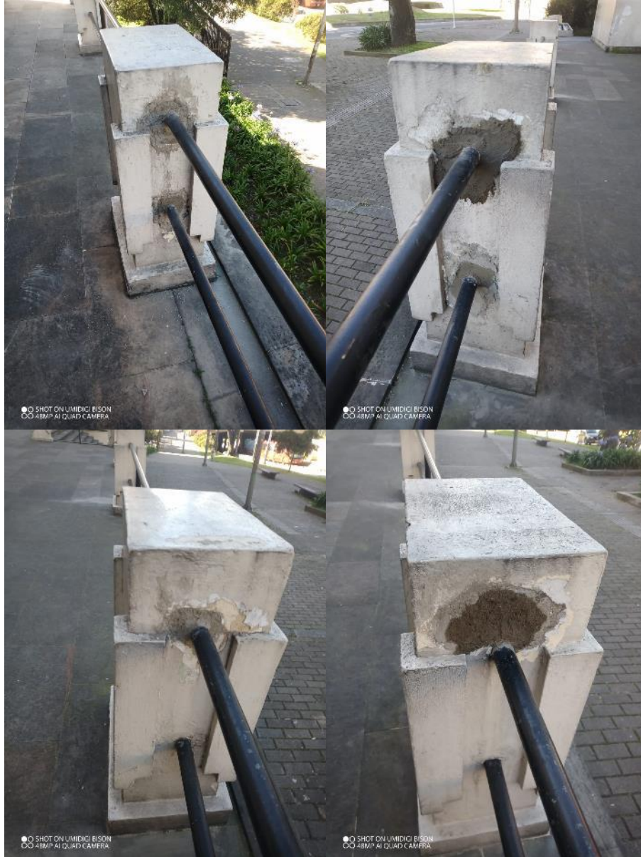
Imágenes126-129: proceso de fijado de las barandas del exterior (fachada norte) del edificio.
