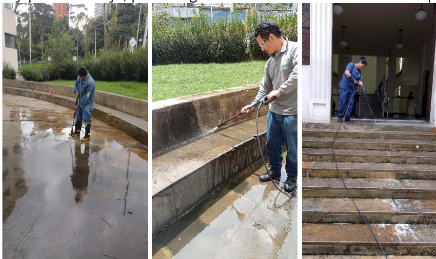
Imágenes 153-155: proceso de lavado piedra muñeca con hidro lavadora
