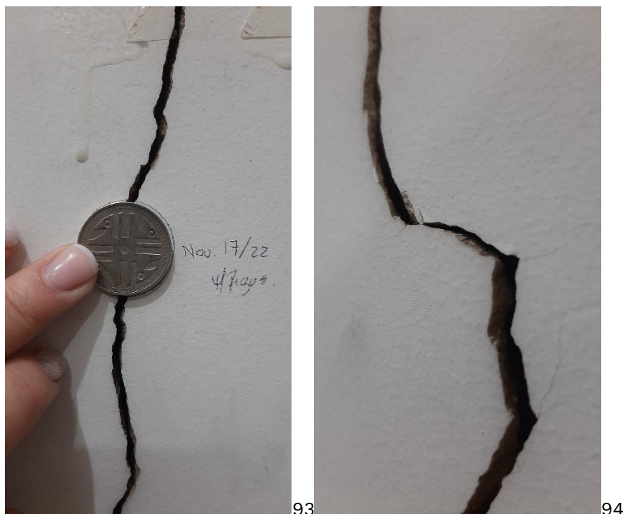
Imagen: seguimiento a grieta de la reserva de fotografía y microfilm
