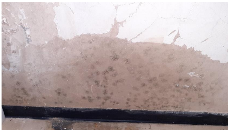
Imagen 83: indicadores de biodeterioro frente a las colecciones PT a menos de 60cm del piso.
