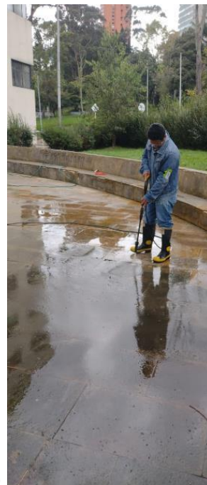
Imágenes 148-150: proceso de hidrolavado de pisos externos (piedra muñeca)
