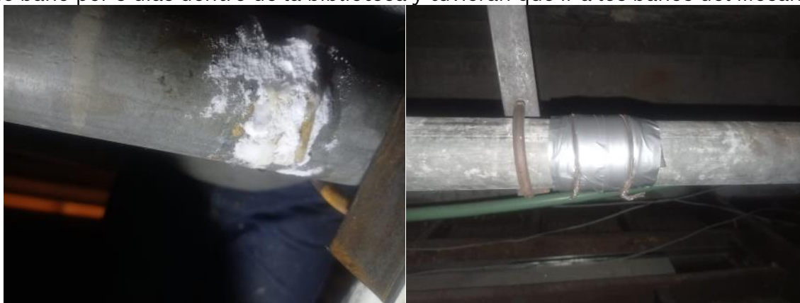
Imágenes 156-157: Proceso de reparación de los tubos hidráulicos del primer piso.
