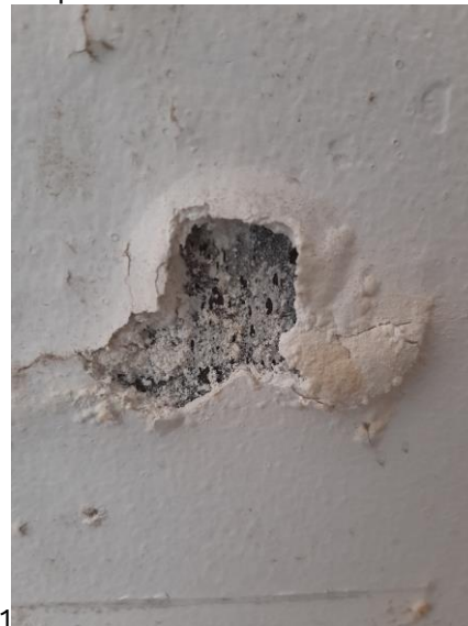
Imágenes: proceso de mantenimiento de la pared occidental, frente al Mosaico y detalle del crecimiento de sales en el mismo muro al costado norte (junto a la puerta de ingreso de la galería Vásquez)
