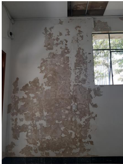
Imágenes: proceso de mantenimiento de la pared occidental, frente al Mosaico y detalle del crecimiento de sales en el mismo muro al costado norte (junto a la puerta de ingreso de la galería Vásquez)
