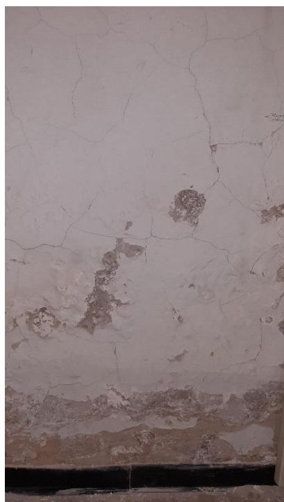
Imágenes: 65. grietas presentes en depósito de material en tránsito y 66. grietas de seguimiento en reserva microfilm.
