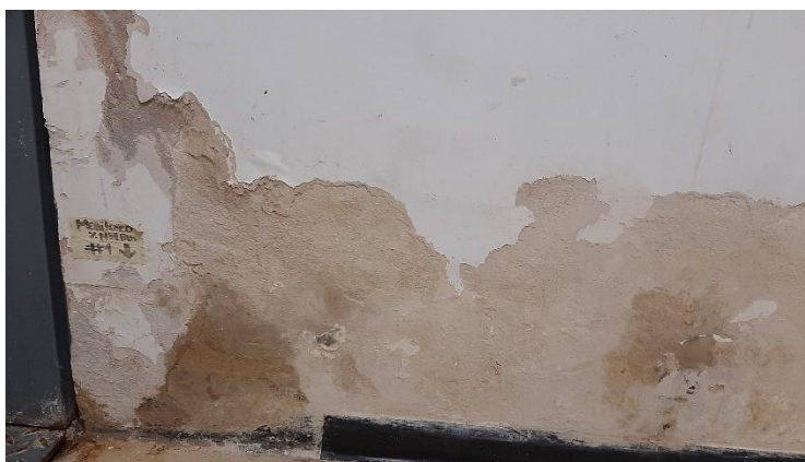
Imagen 82: manchas de humedad junto a la trampa de agua
