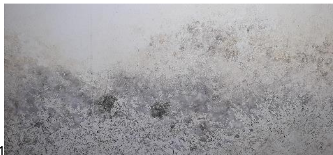
Imágenes 1 y 2: incremento de manchas y otros indicadores de biodeterioro en muro oriental prensa.
