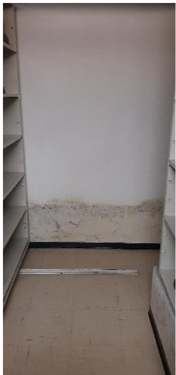
Imágenes 1 y 2: incremento de manchas y otros indicadores de biodeterioro en muro oriental prensa.
