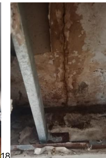
Imágenes 18 y 19: Raspado de pared con humedad y detalle de la reparación de la humedad en el techo
