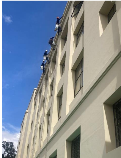
Imágenes 164-165: proceso de pintura de la fachada
