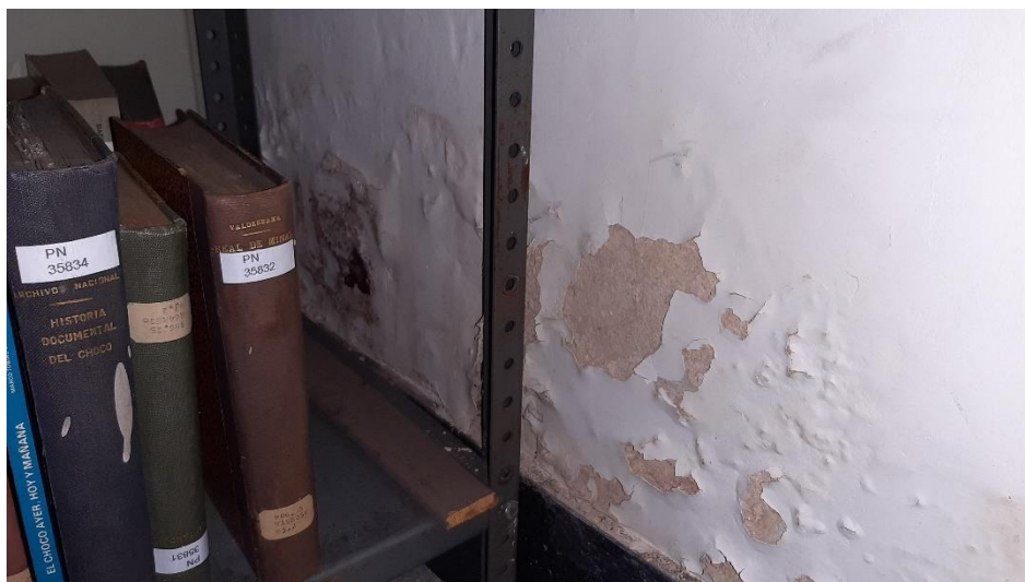
Imágenes: muro sur de la Galería Vásquez, ubicado junto a estantería con signatura PN35832 y frente a las escaleras.
