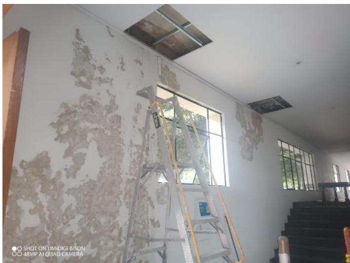
Imágenes 18 y 19: Raspado de pared con humedad y detalle de la reparación de la humedad en el techo
