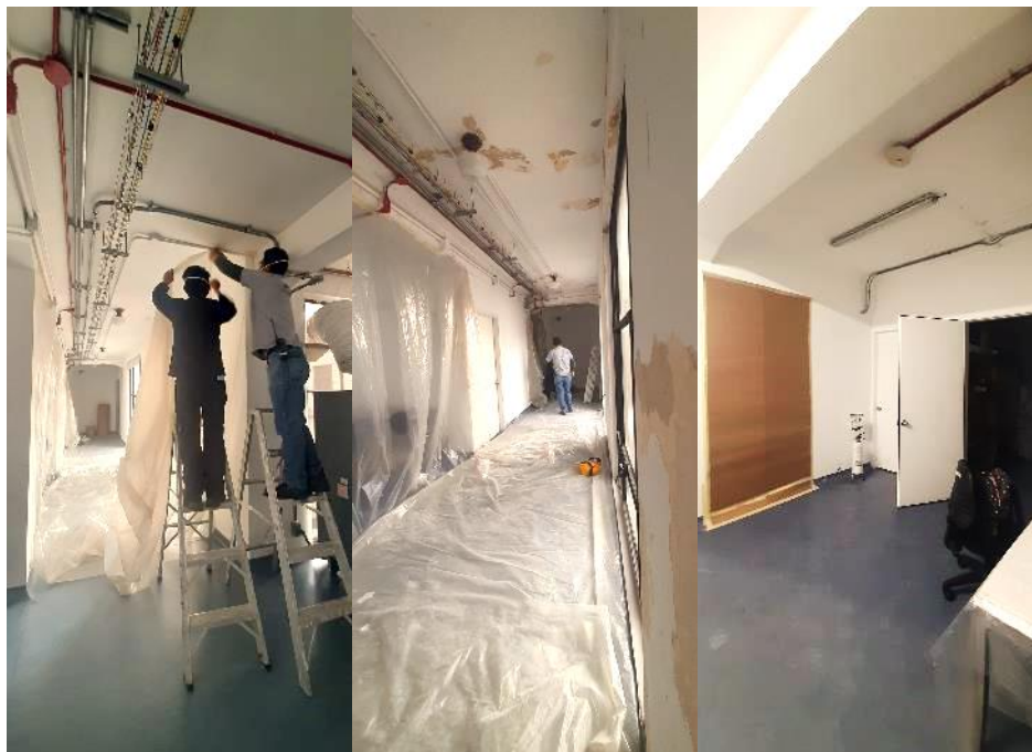
Imágenes 219-221: proceso de mantenimiento en paredes y techos del área de conservación.
