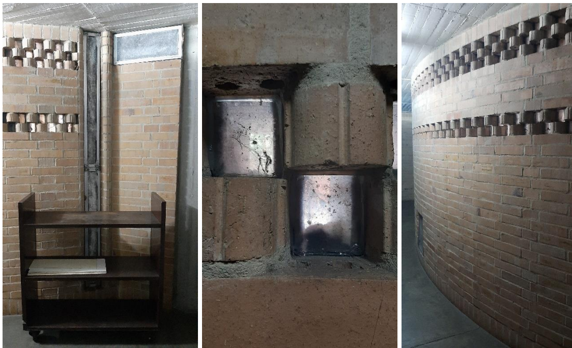
Imágenes 247-249. Sistemas arquitectónicos de ventilación en los depósitos del AGN y ubicación de cebos.
