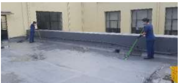
Imagen: mantenimiento a la terraza sur oriental
