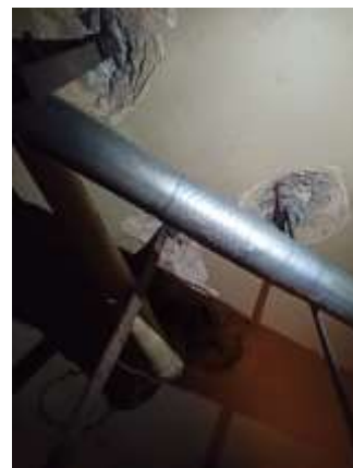
Imagen: detalle de la reparación del tubo
