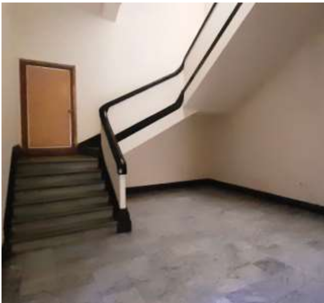
Imagen 39: foto de las escaleras principales del sótano, en enero del 2024.
