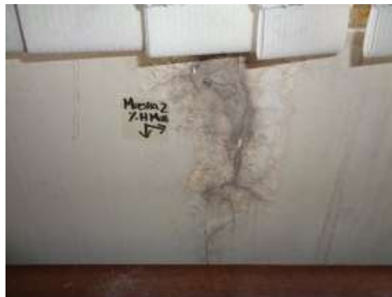
Imagen: Muro norte Sala de Seguridad del Fondo Antigo.
