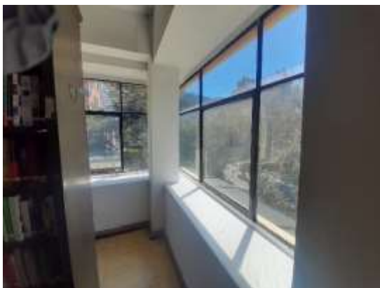
Imagen: ausencia de las persianas de la esquina suroriental reserva bibliográfica.
