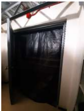
Imagen 13: sellamiento de la puerta que conduce a la signatura T
