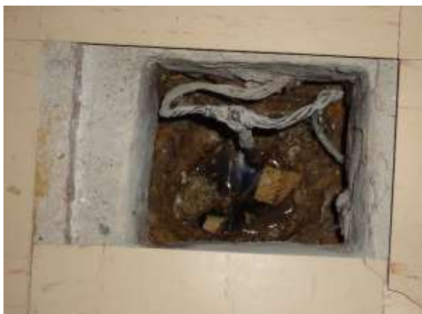
Imagen: indicadores de humedad y agua en el piso de la reserva de prensa
