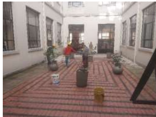
Imagen: proceso de resane y reparaciones a las terrazas internas
