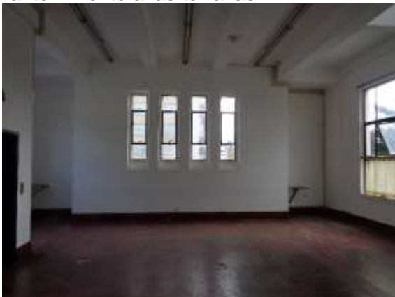
Imagen: cafetería antes de la finalización de las obras. (05 de marzo de 2024)
