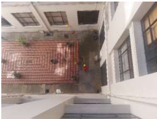
Imagen: proceso de limpieza con hidro lavadora en las terrazas
