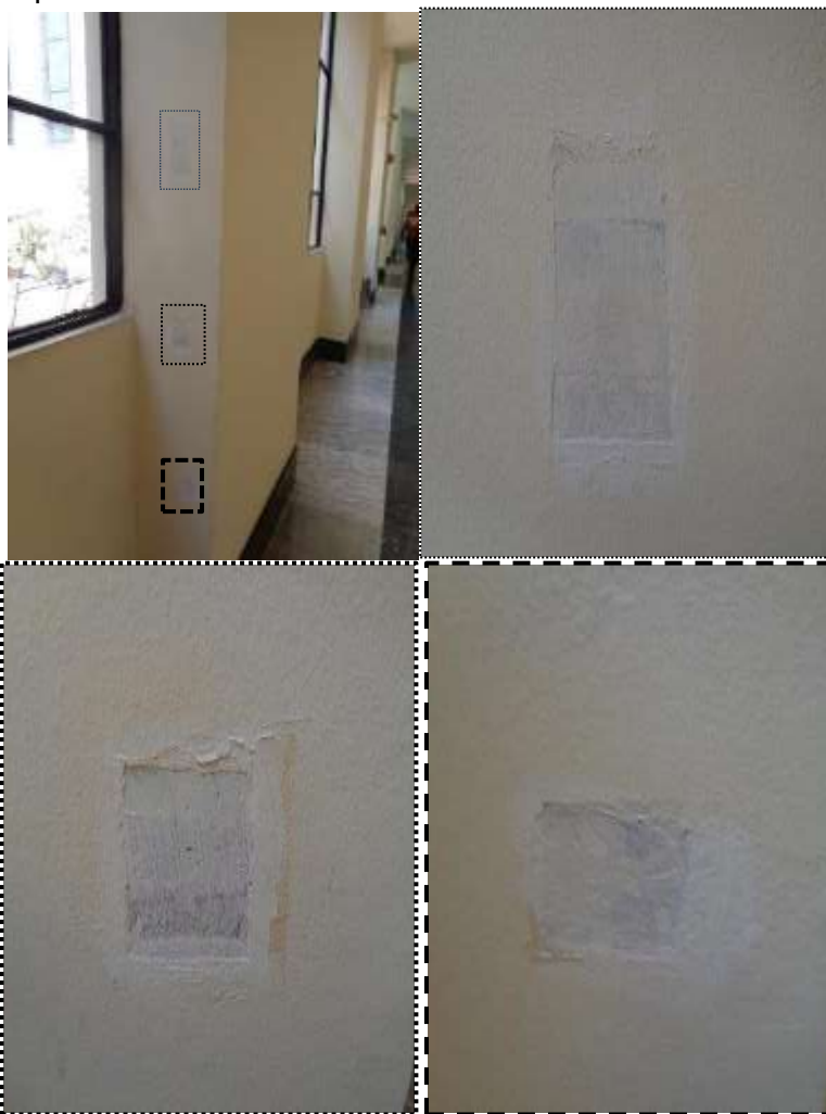
Imagen: Calas estratigráficas tapadas con pintura blanca, aparentemente vinilo.
