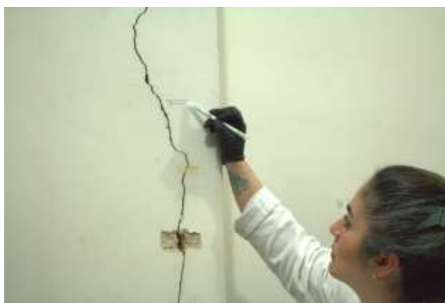
Imagen 86: detalle del seguimiento registrado durante
