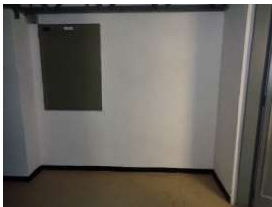
Imagen 36: marzo 2024 después del proceso de mantenimiento. Zona de seguimiento No.3
