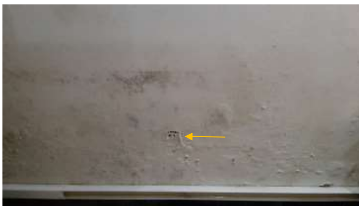
Imagen 4: la zona de seguimiento al %HM (zona de seguimiento #1) de la reserva Vásquez está ubicada a 44cm del piso y 3'10metros de la pared oriental está junto al marco de la puerta del cuarto de los vestidos.
