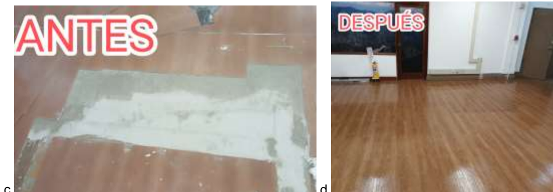
Imágenes: fotografías generales segundo piso y sala de exposiciones del fondo antiguo; a. corredor noroccidental de las escaleras de emergencia del segundo piso; b. sala de exposiciones Fondo Antigo; c. piso laminado de la sala de exposiciones del fondo antiguo antes de ser reparada; d. piso laminado después de la reparación. (fotografías c y d fueron facilitadas por el equipo de administrativa).
