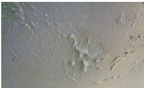
Imagen: indicadores de humedad en los muros de prensa, sales, halos de humedad y manchas de microorganismos.
