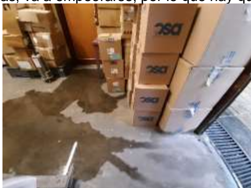
Imagen 17: detalle de las cajas ubicadas junto a la puerta del garaje.
