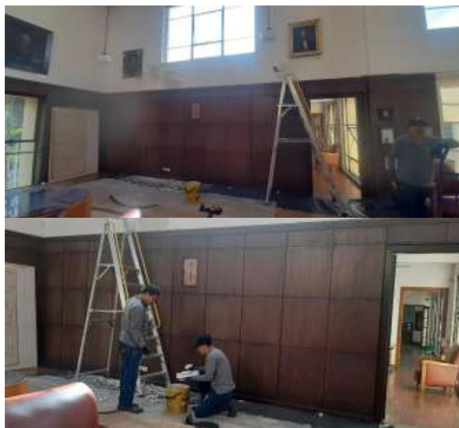
Imagen: proceso de raspado, resane y pintura del muro oriental de dirección.
