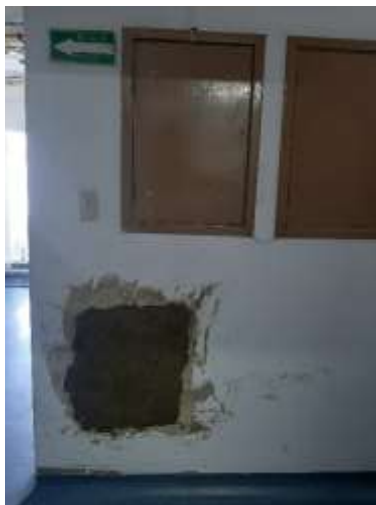
Imagen: Brigada y limpieza general de espacios después del proceso de mantenimiento.
