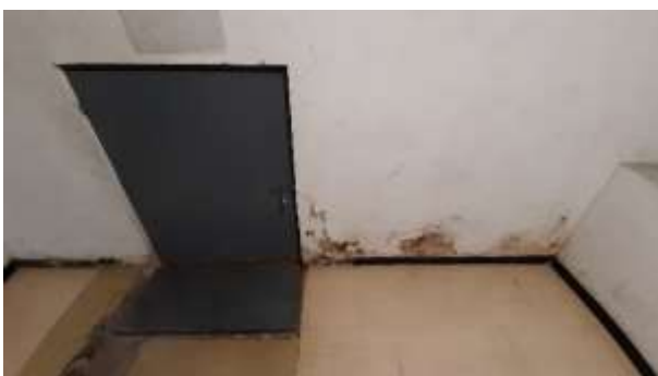
Imagen 37: septiembre de 2021 antes del proceso de mantenimiento. Zona de seguimiento No.1
