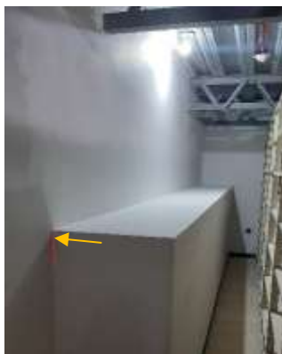
Imagen 2: zona de seguimiento al %HM de la zona de seguimiento #2. Ubicación: Sobre el vértice, a 1'12 metros del piso y 63 cm del marco de la puerta.
