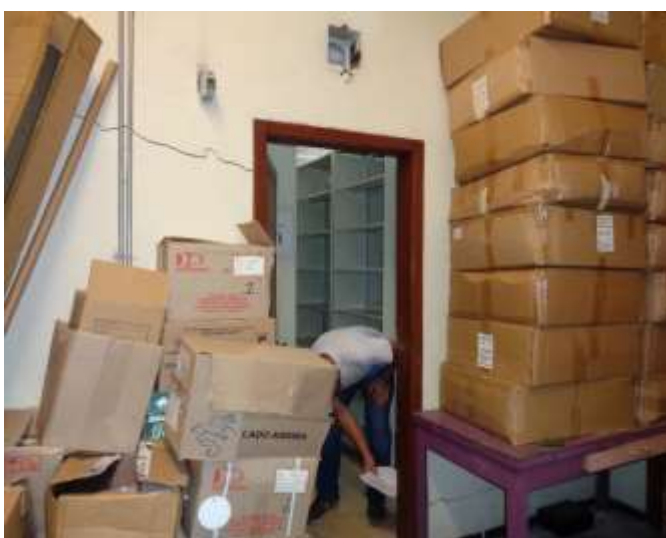
Imagen 77: grietas y fisuras presentes en puerta garaje
