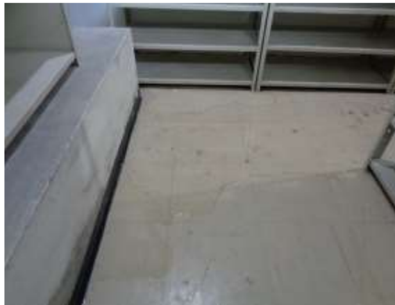
imagen: Filtraciones detalle
