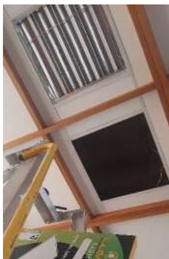
Imagen: proceso de cambio de luminarias
