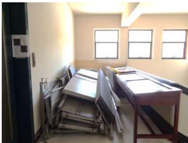
Imagen: corredor de salida del ascensor de carga occidental o escaleras de emergencia del tercer piso.
