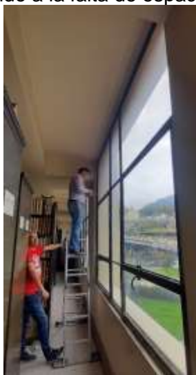
Imágenes: instalación de persianas en Fondo Antigo
