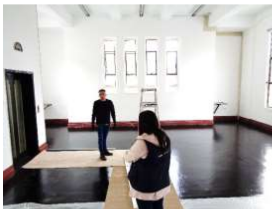
Imagen: fotografía después del proceso de reparación y mantenimiento del piso en cafetería (12 de marzo del 2024)
