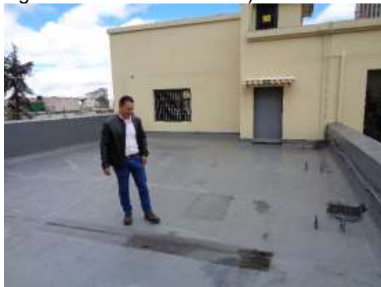
Imagen: Ing. Darwin Campos haciendo visita técnica en la terraza suroccidental.
