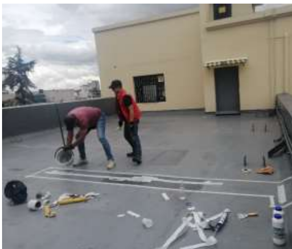
Imagen: proceso de reparación a las grietas presentes en la impermeabilización de la terraza suroccidental
