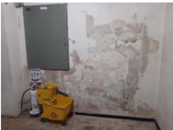
Imagen 35: julio de 2022 antes del proceso de mantenimiento. Zona de seguimiento No.3
