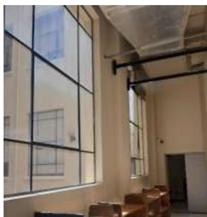
Imagen 23: foto de las ventanas durante la visita técnica.
