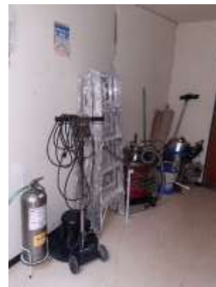
Imagen 21: ubicación inadecuada de material de mantenimiento y limpieza.
