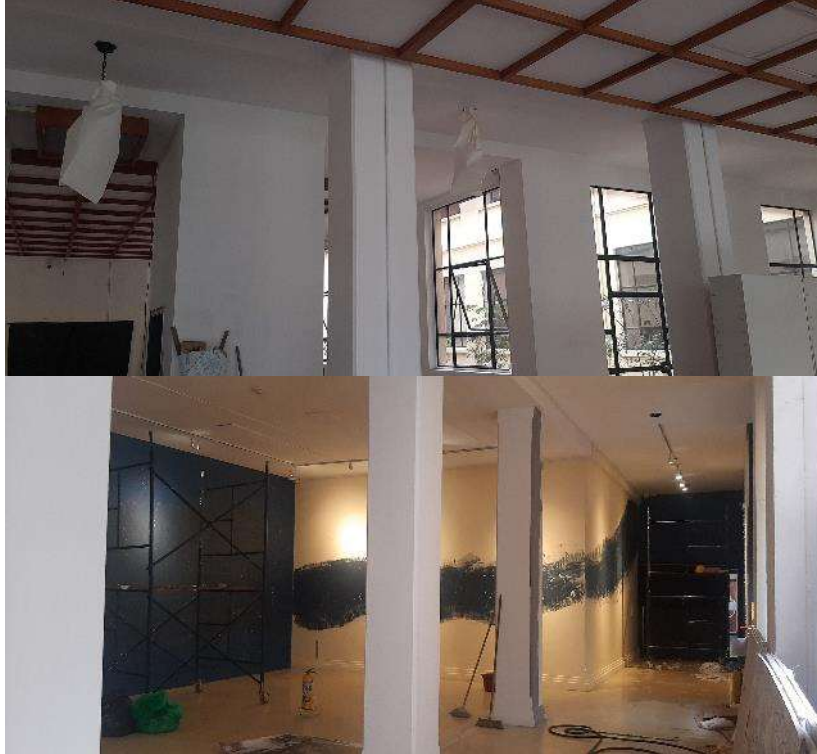
Imagen: forma de protección de las lámparas y sala de exposiciones del primer piso.
