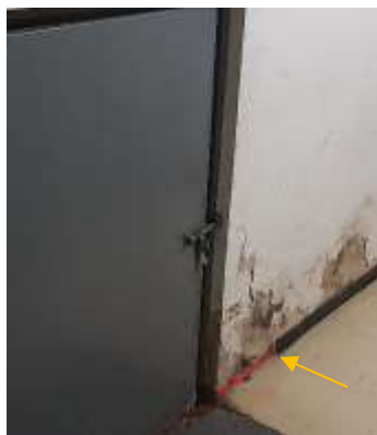
Imagen 1: zona de seguimiento al % Humedad en Muros (%HM) de la zona de seguimiento #1. Ubicación: Sobre el vértice del piso y la pared a 1'10 metros de la pared sur.
