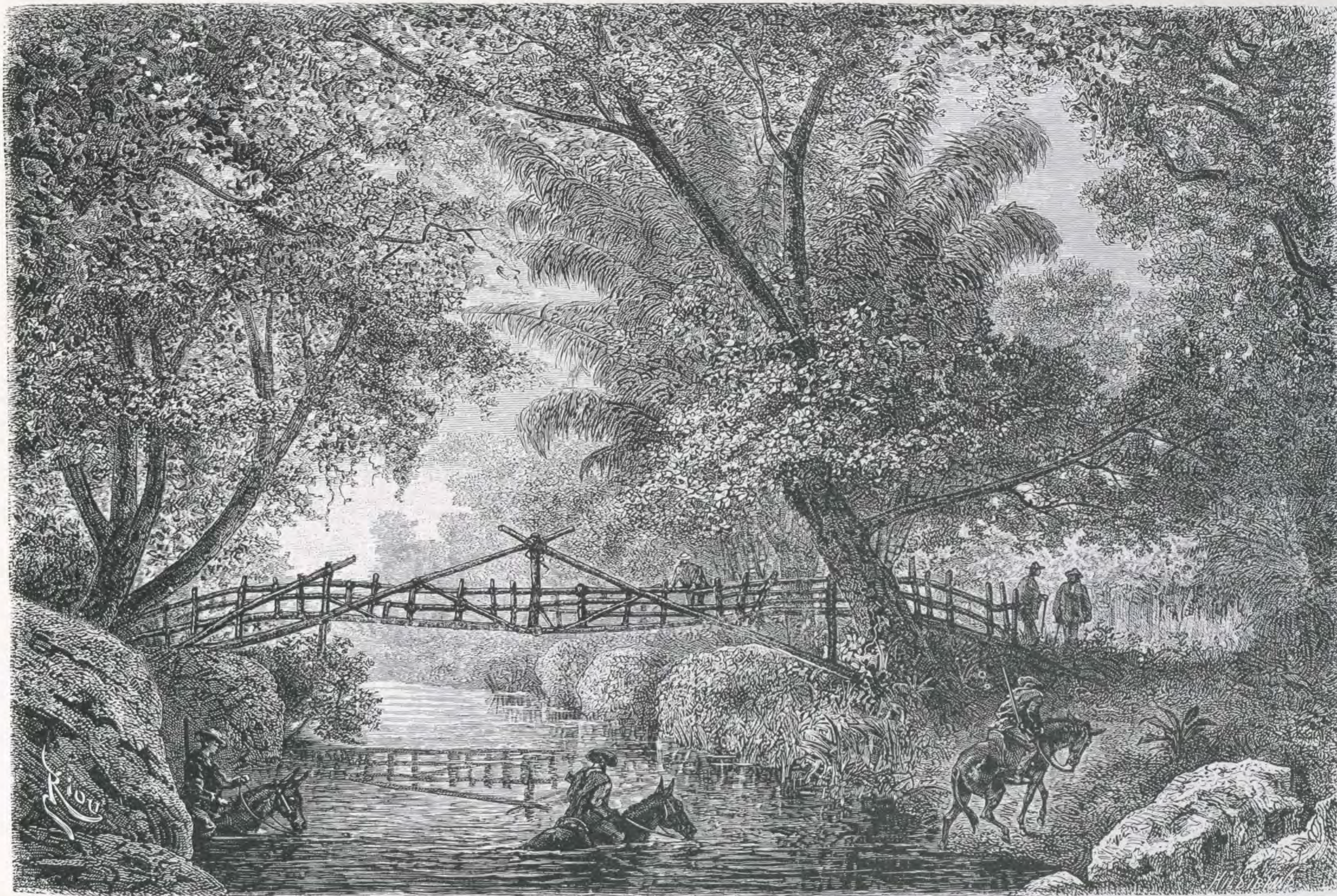
Un puente de guadua en el río la Paila.—Dib. de Riou
