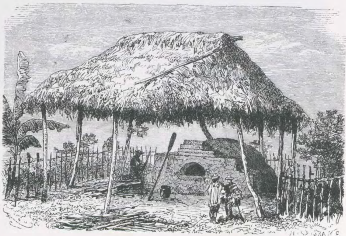
Horno para elaboración de panela.
